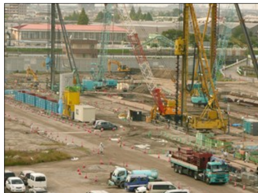
流域下水道終末処理場の現在の工事進捗状況
