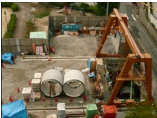
西枇杷島町芳野公園の一角でも管渠敷設中
